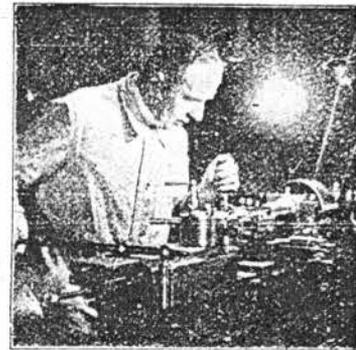
Abb. 3. Nackte Glühlampe 15 Watt, Blendung am Werkstisch ca. 200 Lux.
