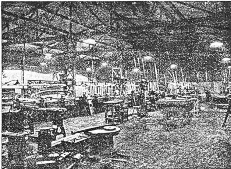
Abb. 5. Automobil-Werkstatt mit Kandem-Tiefstrahler für Allgemeinbeleuchtung und Einzelwerkplatz-Beleuchtung an den Werkplätzen und Maschinen.
